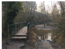
Pont sur l'Yzeron
